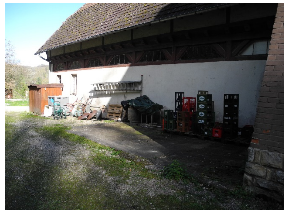
Abb. 11: Blick auf den Teil des nordwestlichen Gebäudetrakts, an dem ein neues Lager errichtet werden soll, von Westen
