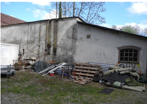
Abb. 16: Blick auf die Mauern der ehemaligen Reithalle und auf den südwestlich angrenzenden Schuppen, wo ebenfalls der Saal geplant ist (Blick von NW)
