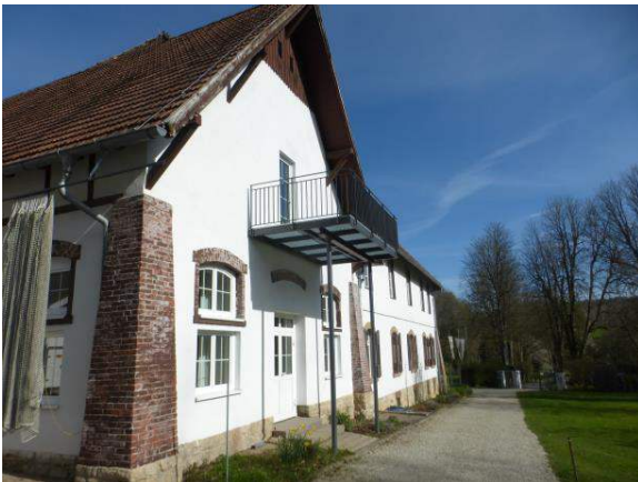
Abb. 14: Blick auf den südöstlichen Trakt des Gebäudes auf die Südostfassade, an der ein neuer Balkon gebaut werden soll
