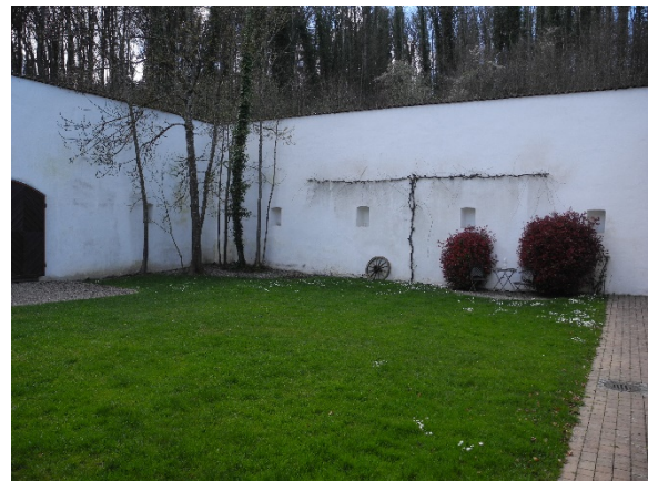
Abb. 15: Blick auf die westlichen Teile der Mauern der ehemaligen Reithalle von Osten, wo der neue Saal entstehen soll
