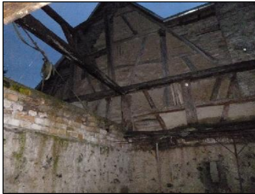
Abbildung 7: Eingestürzter Dachstuhl mit Blick auf die Nachbargebäude im Osten. Für gebäudebrütende Vogelarten ist die mit Efeu bewachsene noch stehende Westfassade gut geeignet, für Fledermäuse besteht nur geringes Habitatpotenzial z.B. in Mauerfugen. (Foto: F. Kurz)
