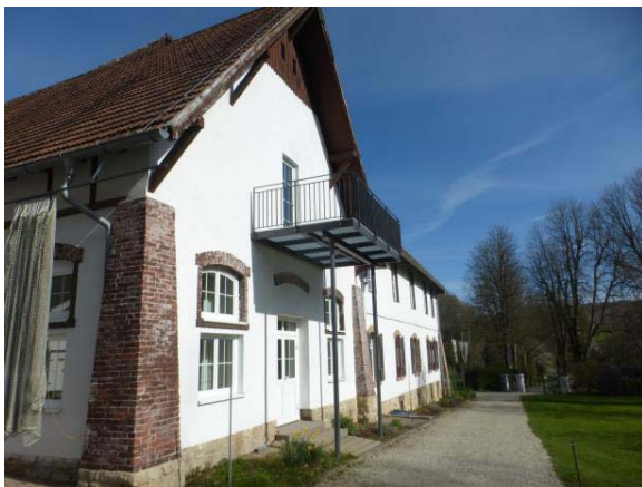
Abb. 14: Blick auf den südöstlichen Trakt des Gebäudes auf die Südostfassade, an der ein neuer Balkon gebaut werden soll
