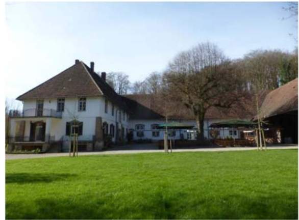
Abb. 13: Blick auf den mittleren Trakt des Gebäudes (hinter der großen Linde in der rechten Bildhälfte), an dem ein neues Vordach geplant ist, von Nordosten
