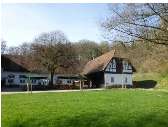
Abb. 10: Blick auf den nordwestlichen Gebäudetrakt (rechter Teil), an dem ein neuer Balkon geplant ist, von Nordosten
