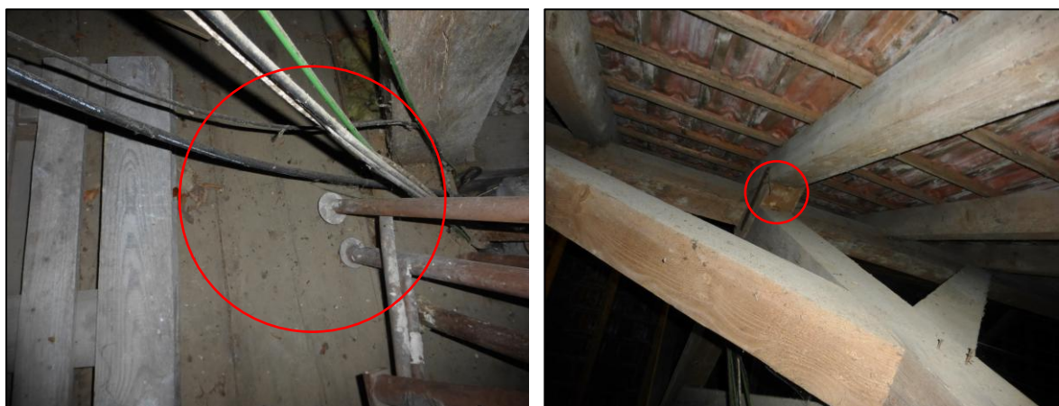
Abb. 3: Kotverteilung und Quartiermöglichkeit an Position 3
