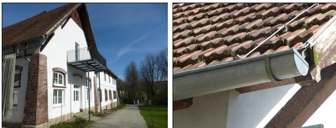
Abb. 6: Gebäudefassade mit Fensterläden und beispielhafte Quartiermöglichkeit im Dachbereich
