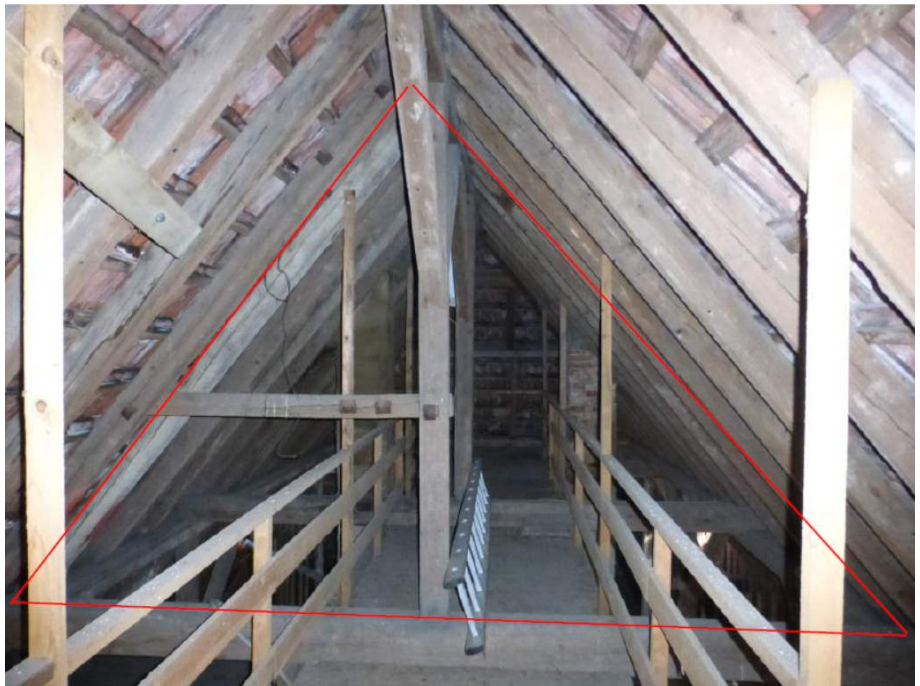
Abbildung 12: Mögliches Fledermausquartier im Dachbereich über der Kehlbalckenlage
