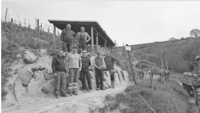
Die neue Trockenmauer mit den Helfern
